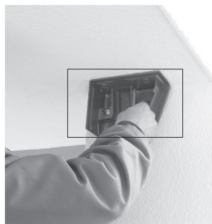
Abb. 05: Bohrbild übertragen (hier Bsp. Deckenmontage)
