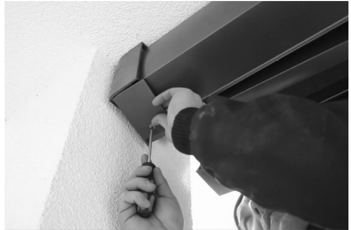
Abb. 16: Konsolen-Abdeckungen entfernen
