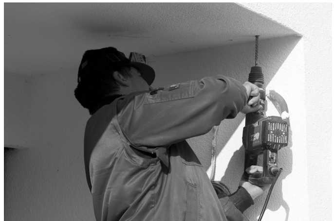
Abb. 06: Bohrungen setzen (hier Bsp. Deckenmontage)
