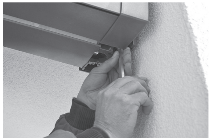
Abb. 11: Sicherungsschrauben setzen
