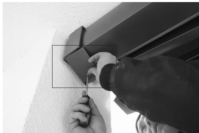
Abb. 12: Abdeckungen bei leicht geöffneter Markise anbringen
