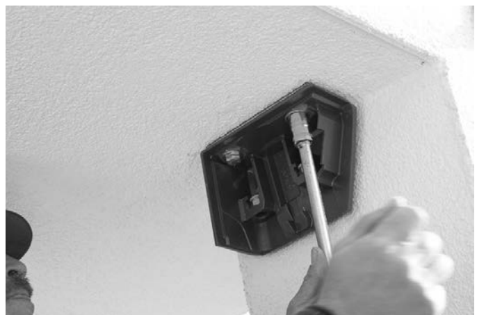
Abb. 08: Befestigungsschrauben anziehen (hier Bsp. Deckenmontage)
