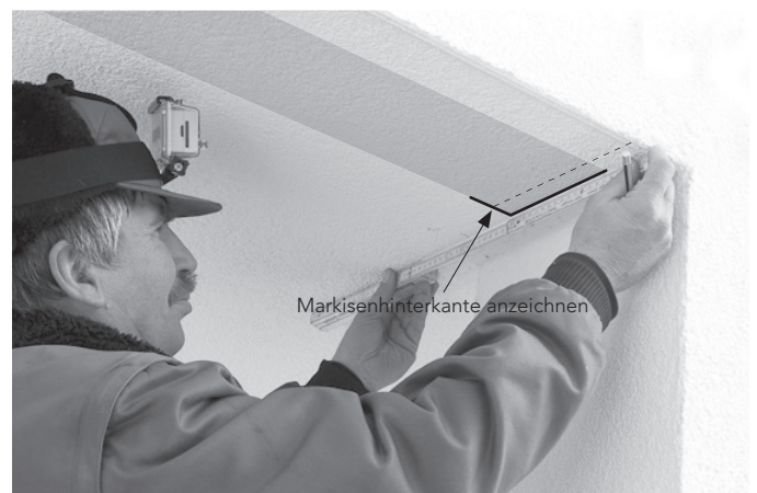
Abb. 04: Markisen-Hinterkante anzeichnen (hier Bsp. Deckenmontage)
