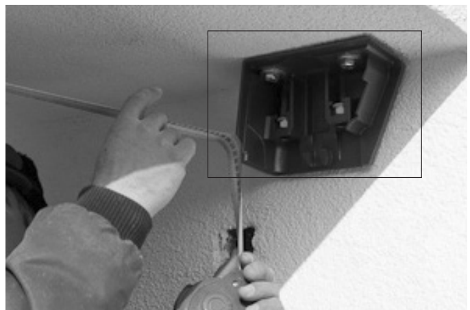
Abb. 07: Konsolen ausrichten (hier Bsp. Deckenmontage)
