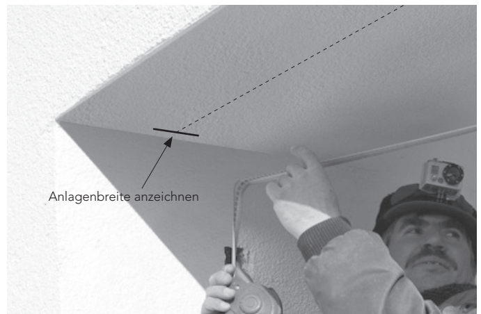
Abb. 03: Anlagenbreite anzeichnen (hier Bsp. Deckenmontage)
